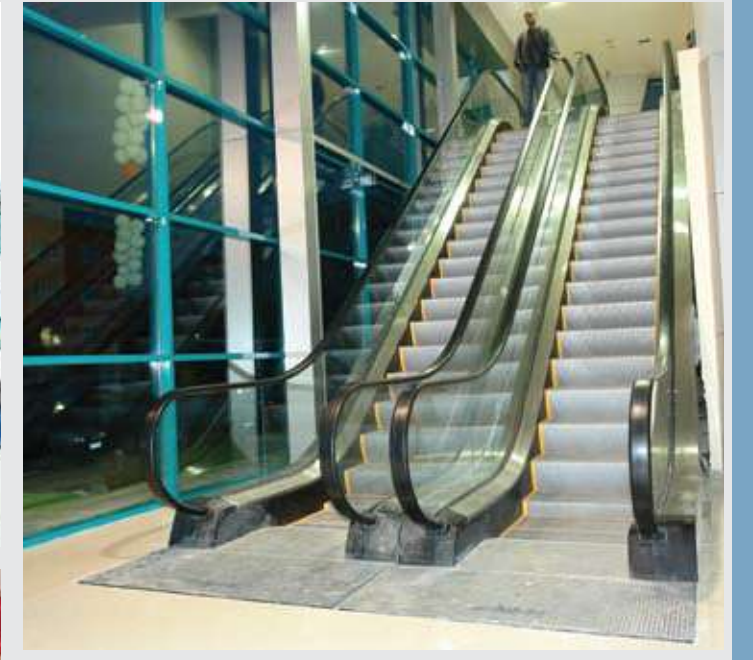
Yer : Karum AVM Uşak Yapıldığı Tarih : 2006 Teknik özellikleri : Yükseklik : 4200 mm. Açı : 35 Basamak genişliği : 800 mm.
