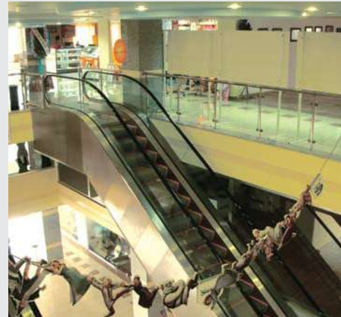
Yer : Altınoluk Molida AVM Yapıldığı Tarih : 2005 Teknik özellikleri : Yükseklik : 6000 mm. Açı : 35 Basamak genişliği : 800 mm.
