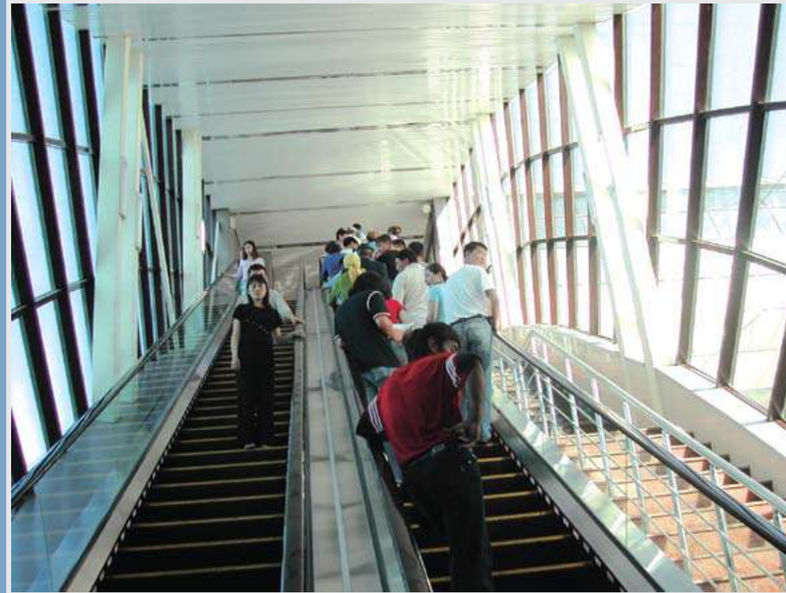
Yer : Astana / Kazakistan Tren İstasyonu Yapıldığı Tarih : 2004 Teknik özellikleri : Yükseklik : 8000 mm. Açı : 30 Basamak genişliği : 1000 mm.
